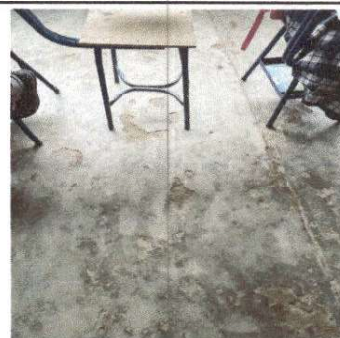
Foto 10: Sustrucción de piso Ceramico
