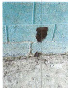
Foto 8: Sustrucción de interruptores dobles.
