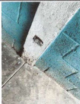
Foto 9: Sustrucción de interruptores dobles en los Salones de Clase, Dirección y Bodega.
