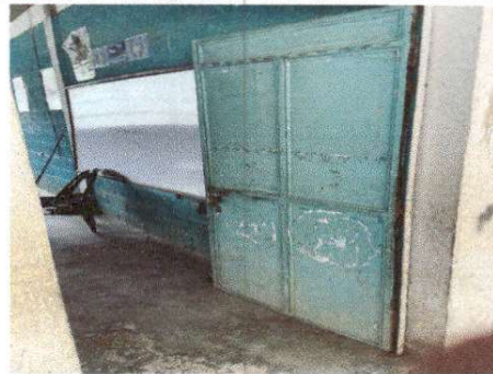
Foto 2: Mantenimiento de puertas de salones de clase.
