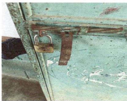
Foto1: Sustitución de chapa
